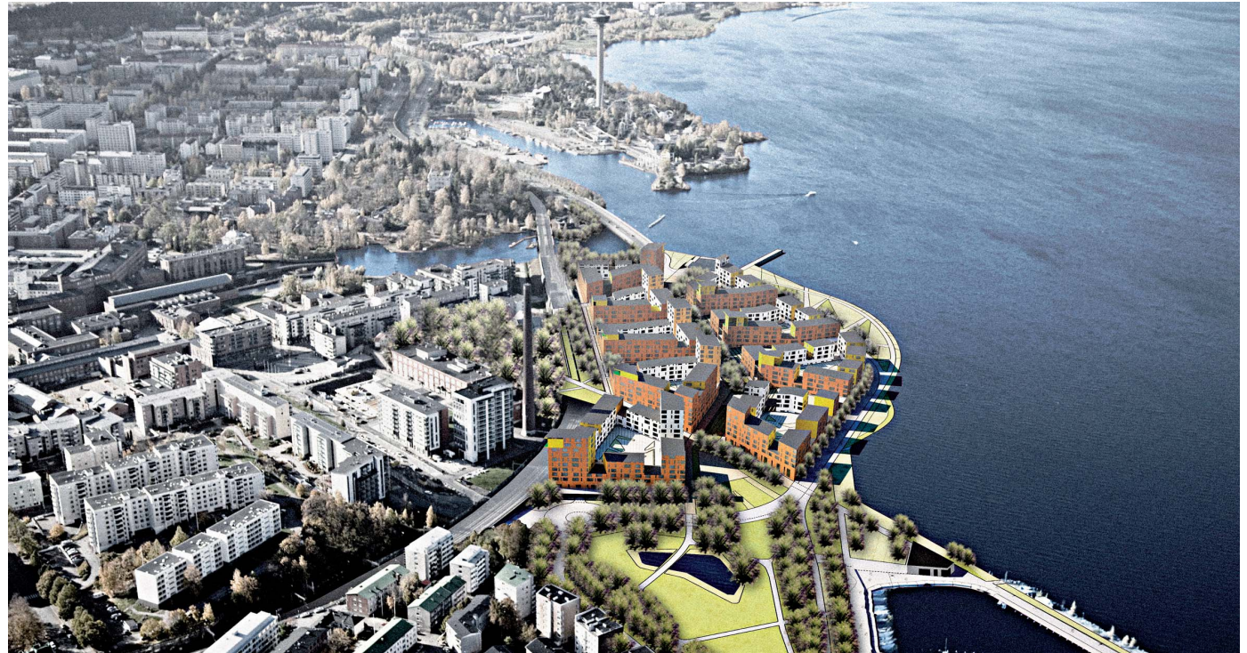
Vasemmalla: Ranta-Tampellan sijainti keskustan kaupunkirakenteessa. Oikealla: Näkymä idästä.
